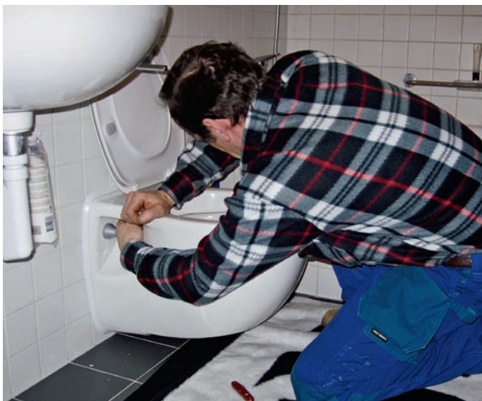
Anschluss an die Zukunft: Ein Sanitärinstallateur richtet ein NoMix-WC in einer Privatwohnung ein (Foto Timur Bürki)
