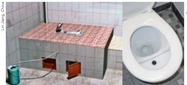
Abb. 2: Zwei Urin separierende Sanitärsysteme: Trockentoilette (links) und NoMix-Toilette mit Wasserspülung (rechts).
