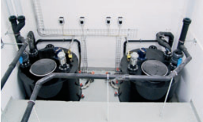
Im Forum Chriesbach wird sogar Frauen- und Männerurin getrennt gesammelt. Das neue Hauptgebäude der Eawag ist komplett mit NoMix-WCs ausgestattet.
